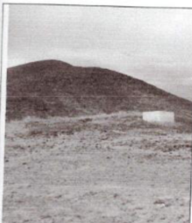
Foto 1.- Vista fotográfica de un tanque de almacenamiento de agua
